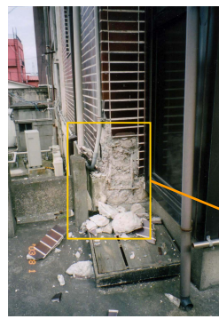
(左写真の左赤枠) (左写真の拡大) (写真-9の右赤枠) 玄関付近の主柱の破壊状況
