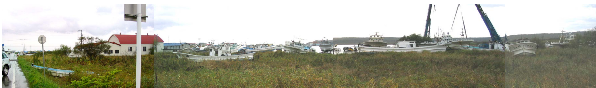
写真-21 大津港で陸上に打ち上げられた漁船
