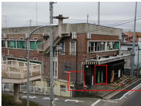
写真-9 鹿島台役場庁舎正面玄関付近 (玄関は2Fになっている)
