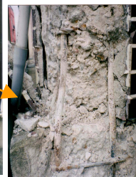
(左写真の左赤枠) (左写真の拡大) (写真-9の右赤枠) 玄関付近の主柱の破壊状況
