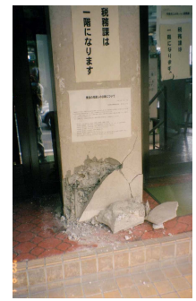
(左写真の左赤枠) (左写真の拡大) (写真-9の右赤枠) 玄関付近の主柱の破壊状況
