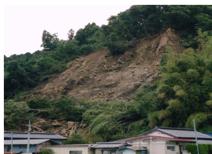
写真-5 矢本町鹿妻地内の住家裏の斜面崩壊
