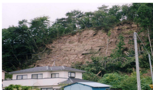
写真-6 矢本町地内の住家裏の斜面崩壊
