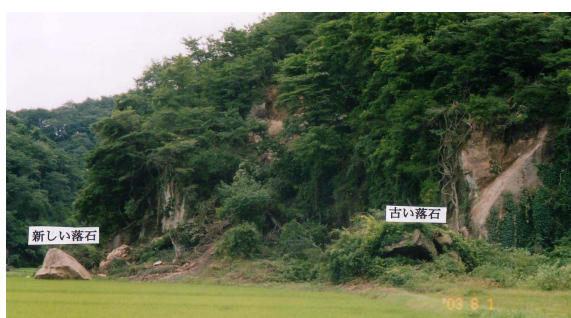
写真-4 松島町手樽地内の崖崩れ
