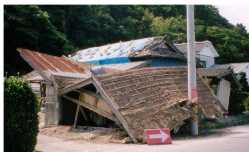
写真-7 木造家屋の倒壊例
