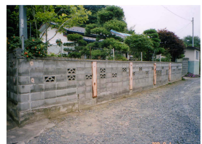
写真-14 補強ブロック塀
