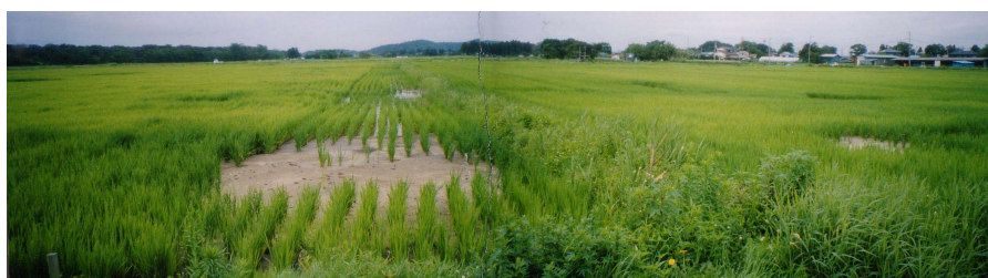
写真-2 大量の砂の噴出により緩い起伏面となった牛網地区内の田面
