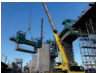
写真-4 緊張足場
