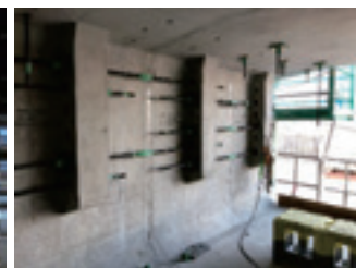
写真-5 引き寄せPC鋼
