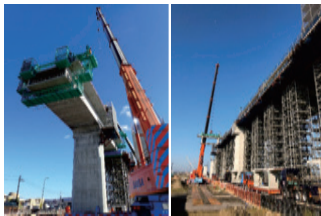
写真-1 片持ち張出し架設 固定支保工架設
