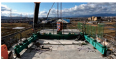
写真-6 仮固定装置 (スパンバイスパン架設)
