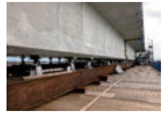
写真-8 セグメント仮支持
