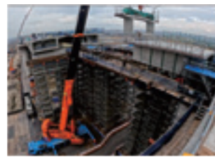
写真-7 セグメント仮置き
