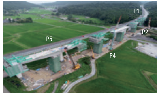
写真-1 張出し施工状況
