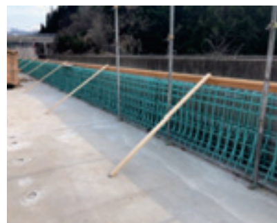
写真-2 埋設型枠設置状況
