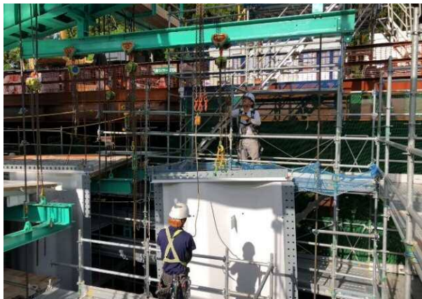
写真-1 波形鋼板の架設状況
