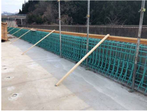
写真-3 埋設型枠の設置状況
