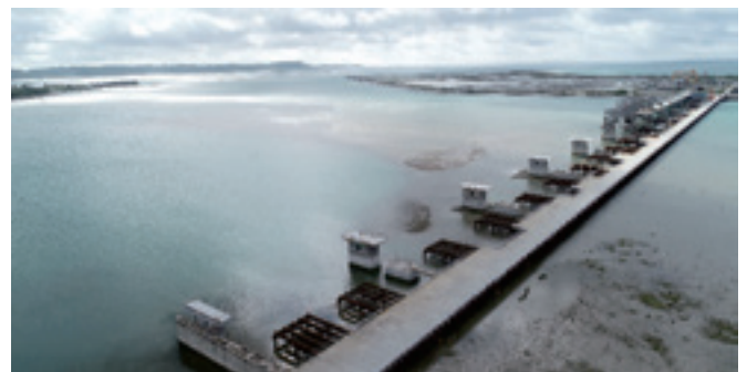
写真-5 現況写真(2022年5月)
