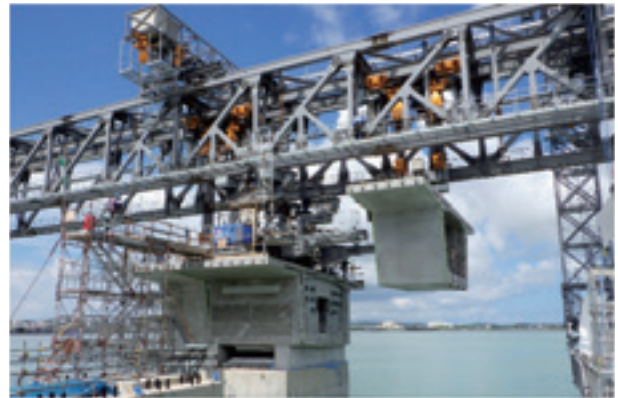
写真-4 基準セグメント架設状況
