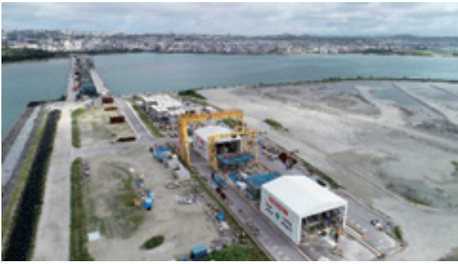
写真-1 セグメント製作ヤード
