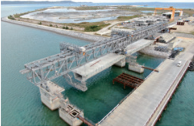
写真-2 架設全景(人工島側)
