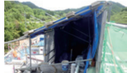
写真-6 既設壁高欄撤去工の養生
