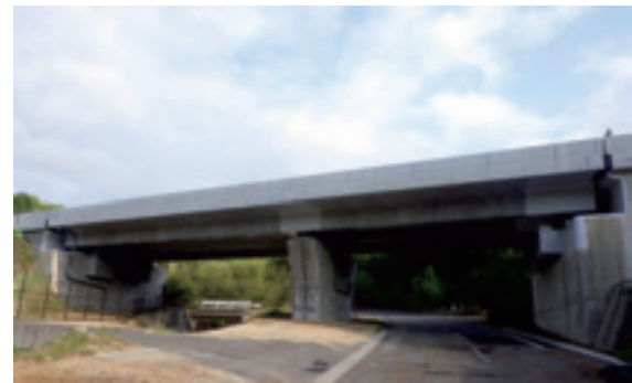
写真-7 工事完了全景
