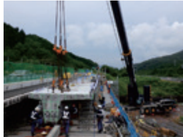
写真-3 セグメント架設
