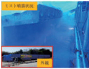
写真-2 セグメントミスト養生
