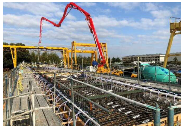
写真-2 主桁セグメント打設状況
