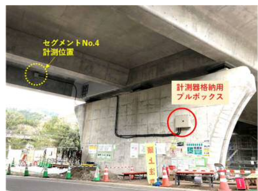
写真-4 実橋における計測状況
