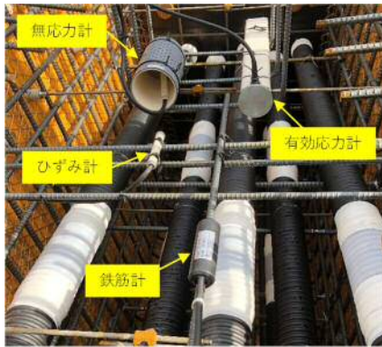
写真-3 計測機器の設置状況
