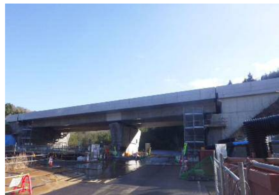
写真-5 主桁拡幅完了状況
