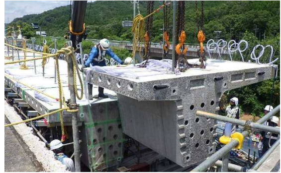
写真-1 セグメント架設状況
