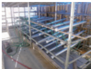
写真-1 空冷パイプクーリング状況
