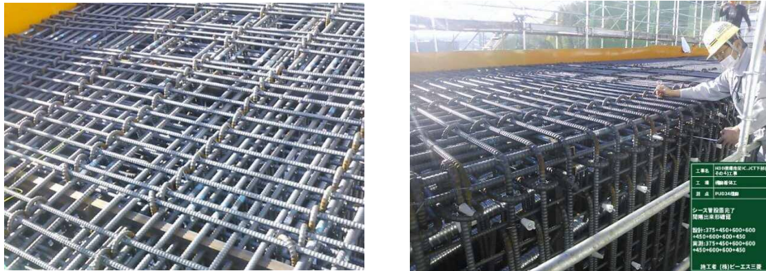
写真-7 配筋状況
