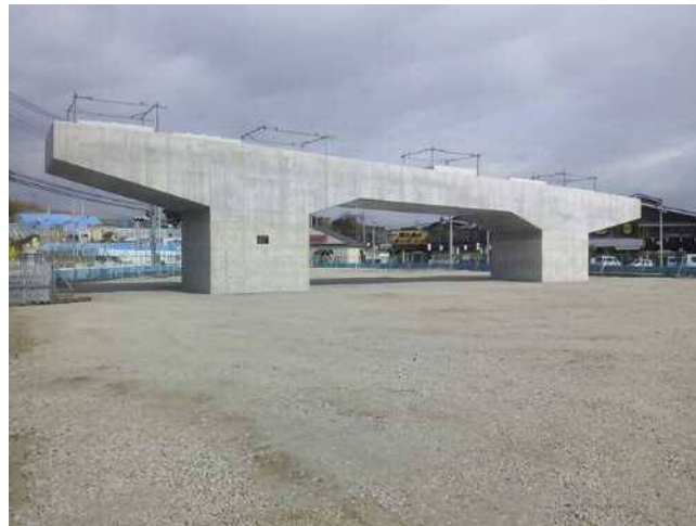
写真-14 PUD24 橋脚全景
