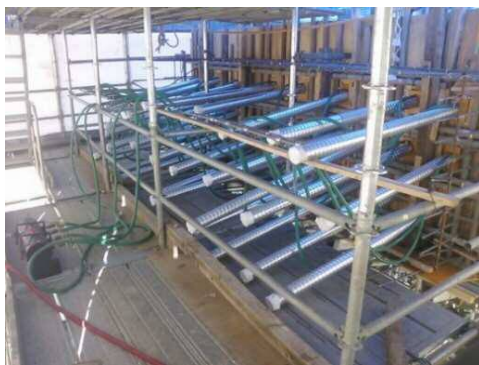
写真-1 空冷パイプクーリング状況
