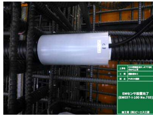
写真-9 EM センサー設置
