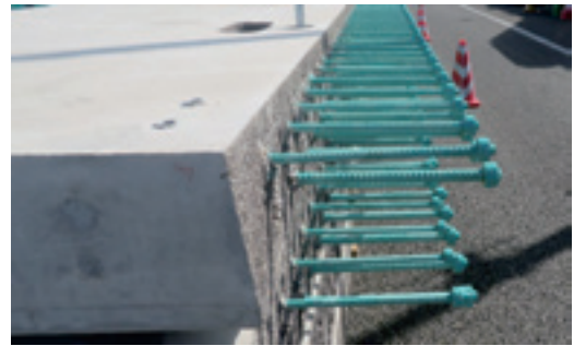
写真-1 中間支点上床版の継手形状
