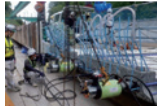
写真-8 下り線の緊張状況
