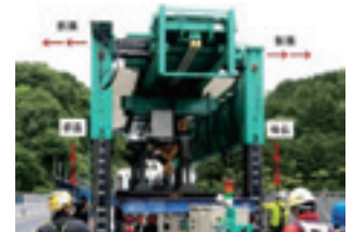
写真-3 脚の拡張・伸長状況
