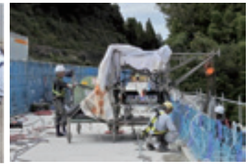
写真-7 架台を用いた2次緊張(上り線施工時)
