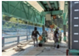
写真-5 脚部連結トラスと屋根材
