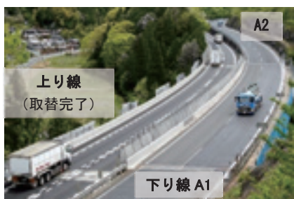
写真-1 大谷橋全景(下り線施工前)
