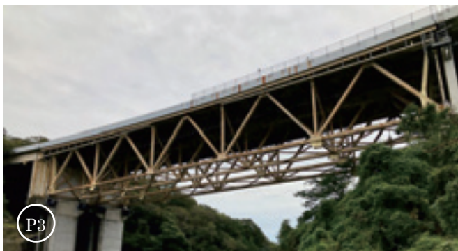
写真-1 四十八瀬川橋 P2～P3 径間（手前が上り線）
