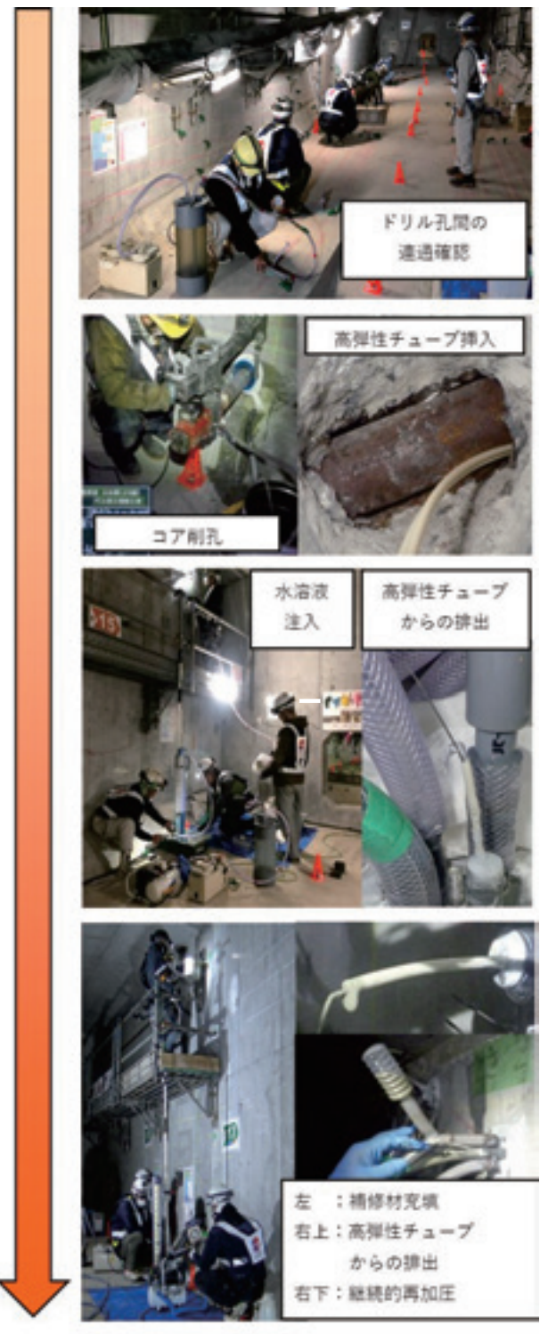
写真-3 リパッシブ工法によるグラウト再充填
