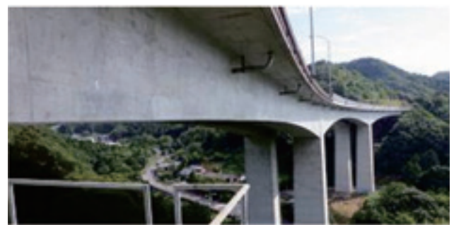
写真-1 土丸橋の外観（手前が上り線）
