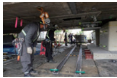
写真-1 鋼製ブラケット設置状況
