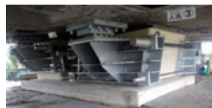
写真-2 鋼製ブラケット設置完了
