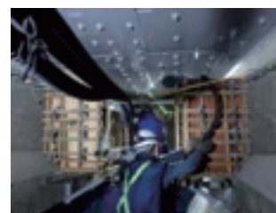
写真-8 モルタル打設状況
