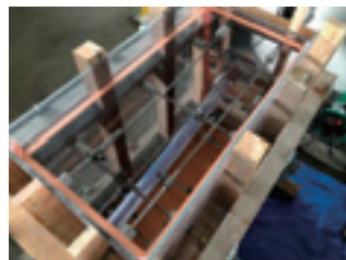
写真-3 試験体型枠組立状況
