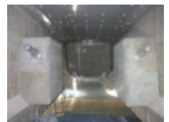
写真-9 外ケーブル緊張完了
