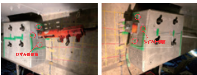
写真-5 計測状況（起点側） 写真-6 計測状況（終点側）
