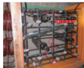
写真-7 熱電対配置状況
