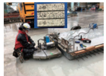
写真-2 床版試験体切断状況
