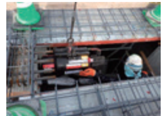
写真-4 Y2 通り緊張作業状況
