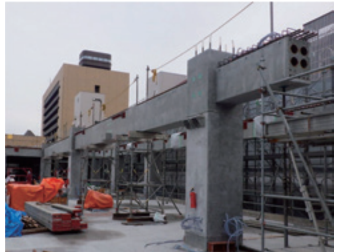
写真-2 Y2 通り桁梁
