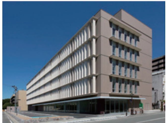
写真-1 建物外観
