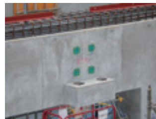
写真-3 スパン梁支承部
