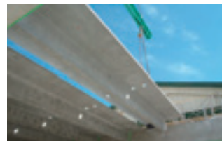
写真-4 ST 床板架設状況
