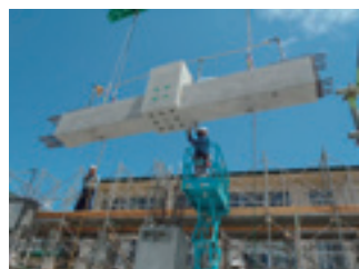
写真-3 桁梁架設状況
