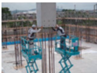
写真-2 柱架設状況
