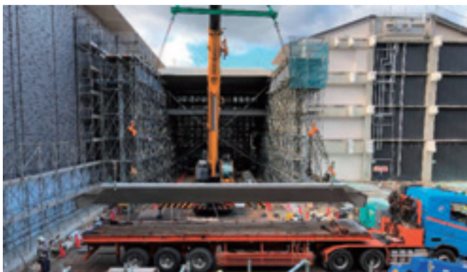
写真-3 PC屋根版の搬入・架設状況
