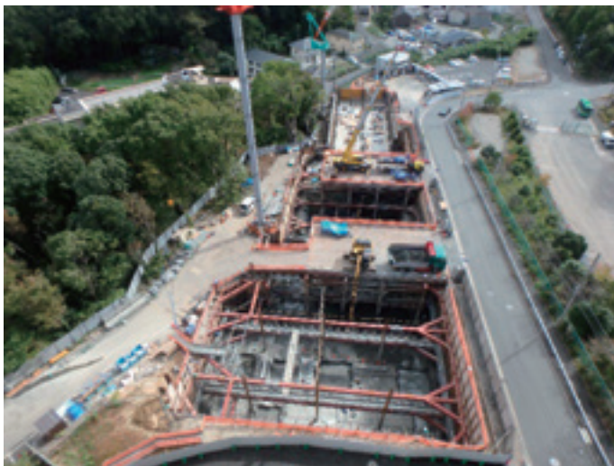
写真-3 地下工事施工状況
