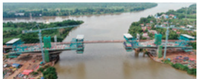
写真-9 施工状況
