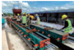
写真-4 ストラット製作状況
