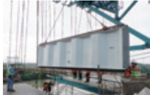
写真-2 波形鋼板架設
