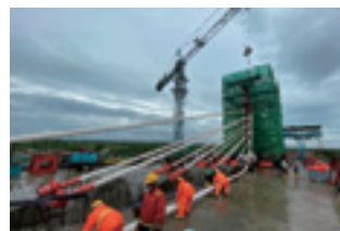
写真-7 斜材架設
