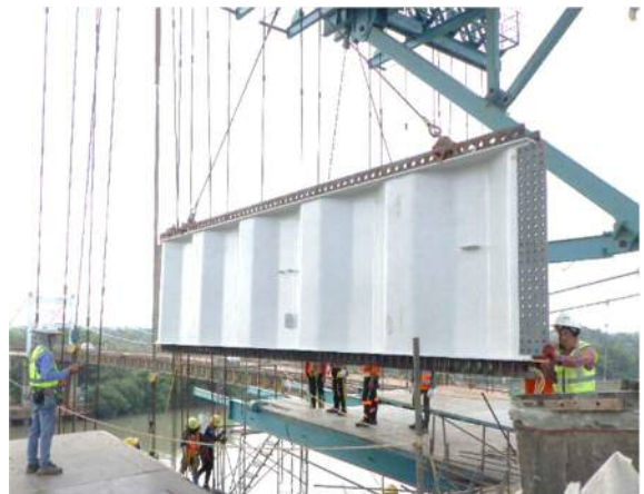
写真-8 電動ホイスを用いた波形鋼板の設置状況
