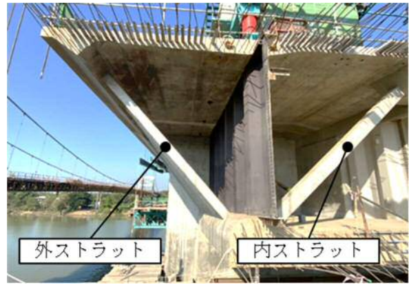
写真-9 ストラット配置状況
