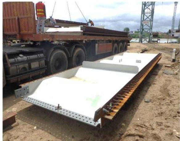
写真-6 波形鋼板 搬入
