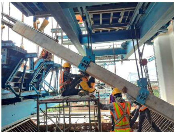
写真-12 内ストラットの架設状況
