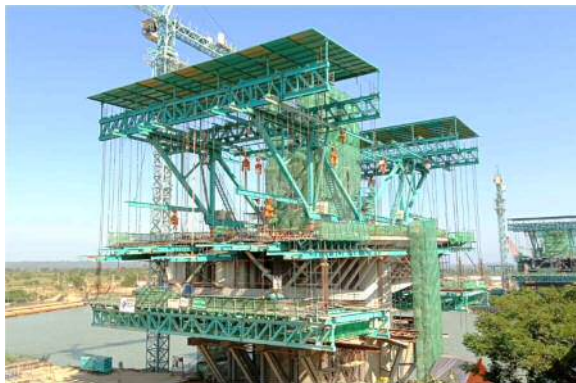
写真-3 超大型移動作業車（フォームトラベラー）
