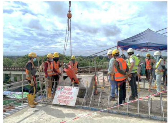
写真-13 内ストラットの緊張状況
