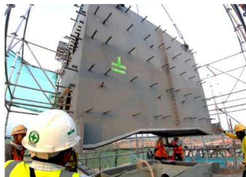
写真-16 分割した鋼殻の組み立て
