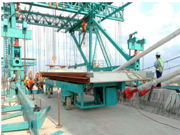
写真-7 自走式運搬車による橋面運搬
