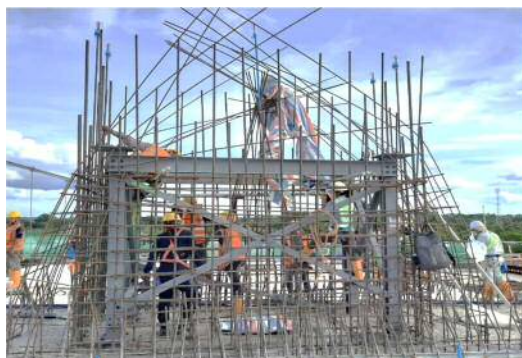
写真-15 鋼殻架台の設置
