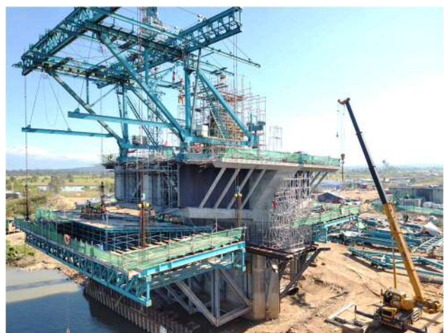
写真-2 作業台・型枠設備の吊り上げ
