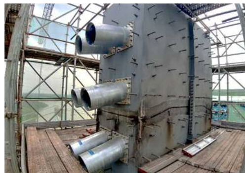
写真-18 鋼殻組立て後の状況
