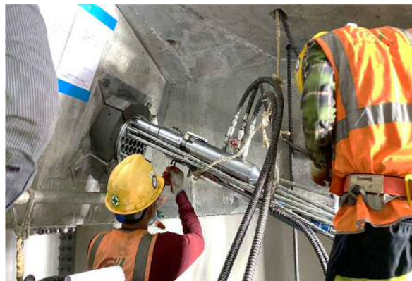
写真-26 斜材緊張作業
