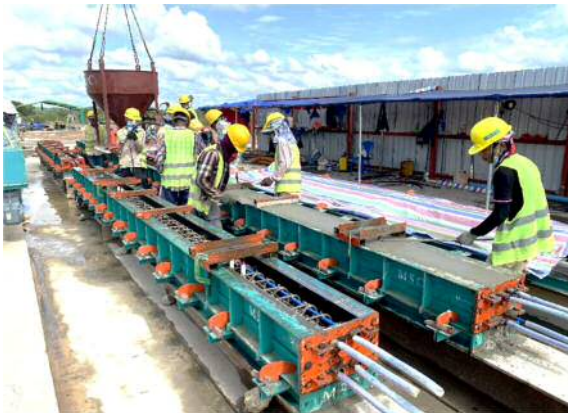
写真-10 現場ヤード内におけるストラット製作状況
