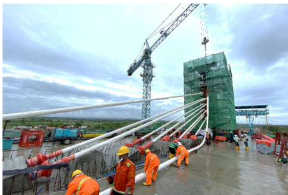
写真-25 斜材架設状況
