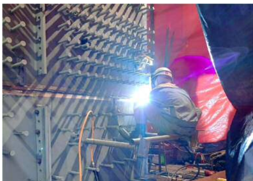
写真-17 半自動溶接による一体化
