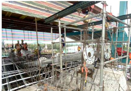
写真-24 リセスパイプ設置・固定状況
