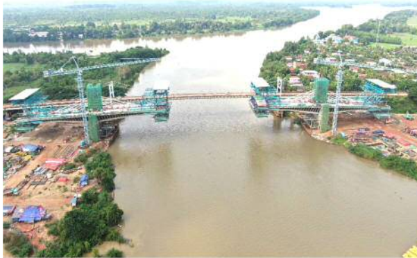
写真-27 2022年6月 施工状況
