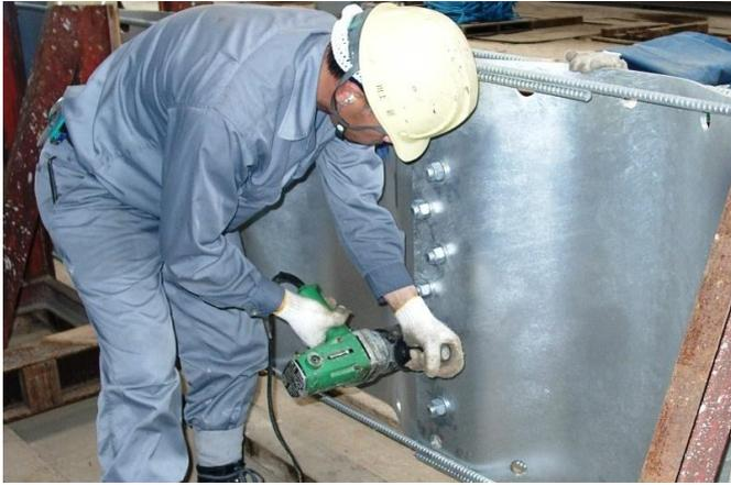
写真-2 ボルト締付状況
