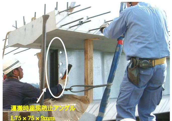
写真-4 吊りワイヤー設置状況
