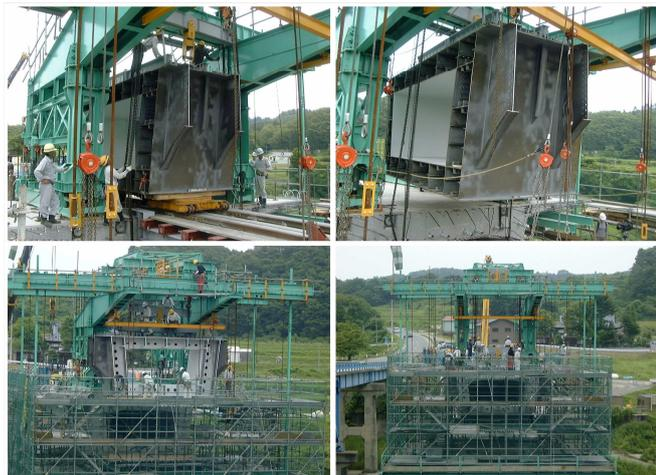
写真-2 接合桁(鋼殻セル)架設
