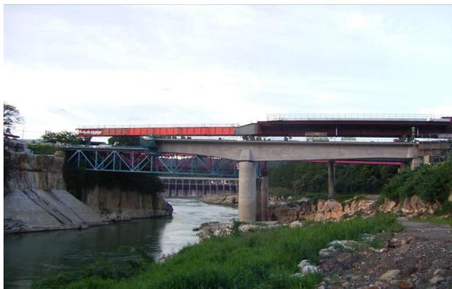
写真-4 鋼桁送り出し(側方から)
