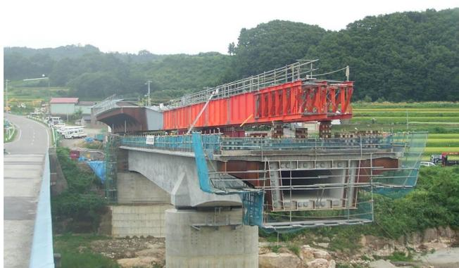
写真-3 鋼桁送り出し(A1側から)
