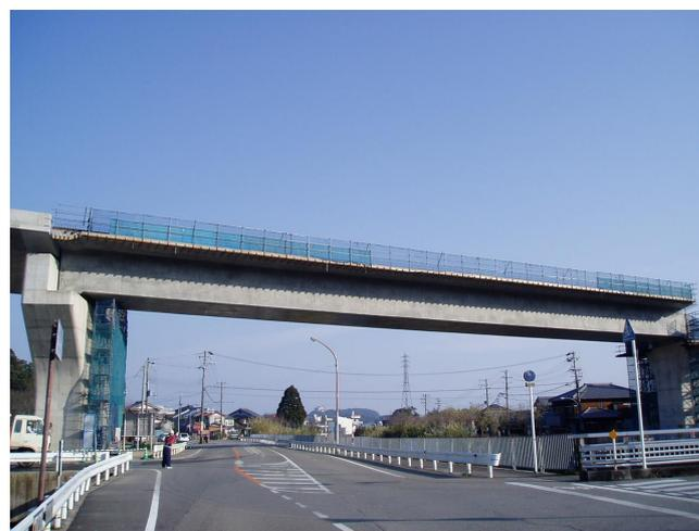
写真-2 支保工撤去後(写真右側がP6橋脚)
