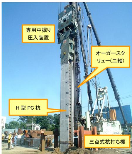
写真-1 試験施工状況
