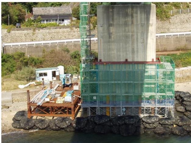
写真-3 仮設設備設置状況(P1橋脚)
