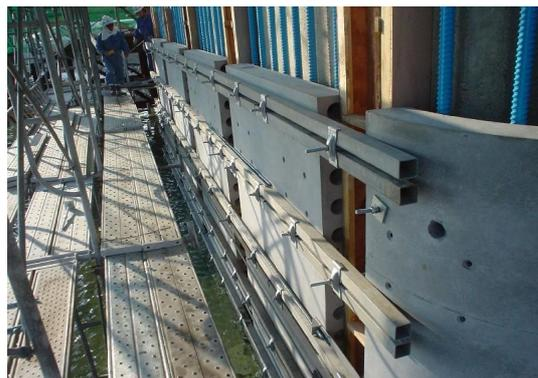
写真-6 一次コンクリート型枠組立状況
