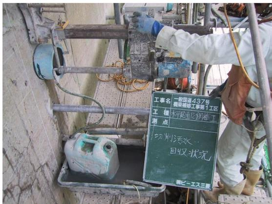
写真-4 切削汚水回収状況
