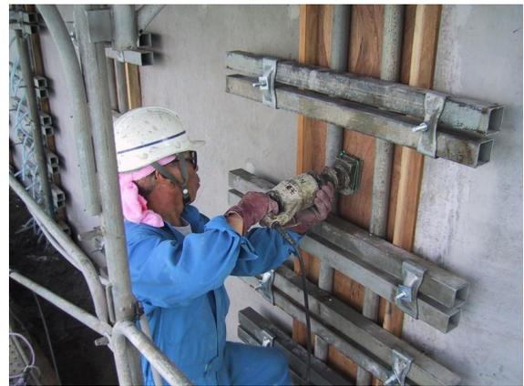
写真-7 二次コンクリート型枠組立状況
