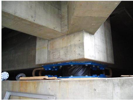
写真-1 免震装置の設置状況
