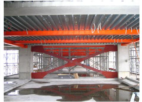
写真-2 S ブレースの設置状況
