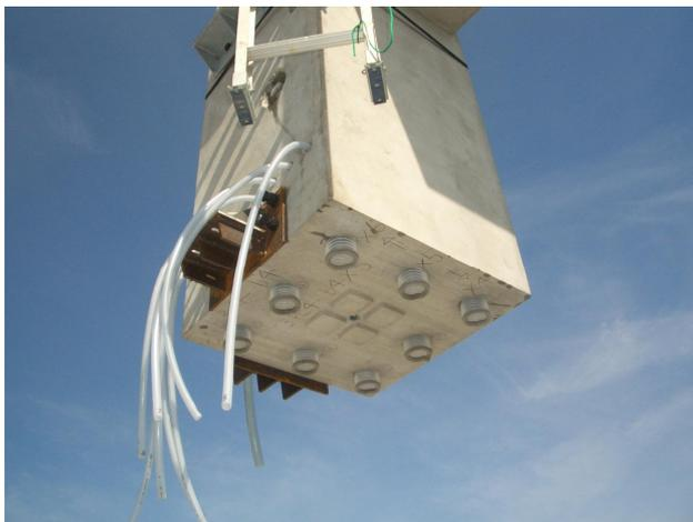
写真-6 PCaPC 柱脚部底面
