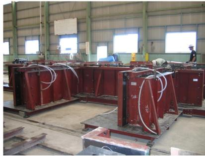
写真-9 柱型枠状況
