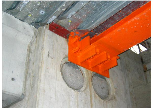
写真-3 PCa 柱-PCa 梁-S 梁取合状況
