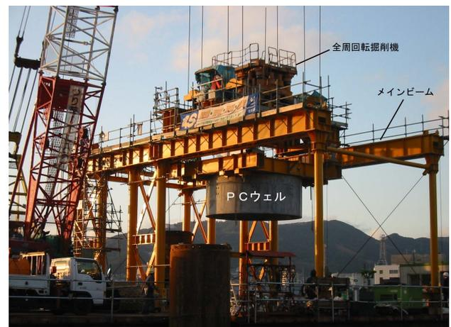
写真-3 PCウェル架設状況
