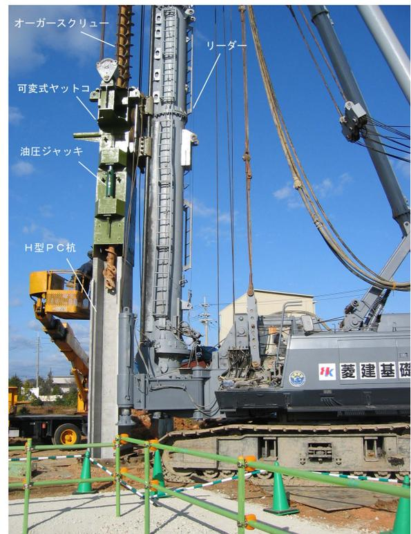
写真-6 施工機械 側面
