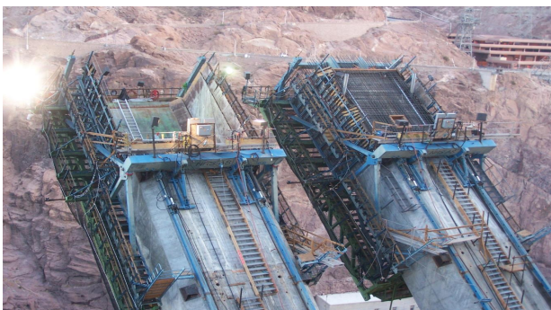
写真-4 移動作業車
