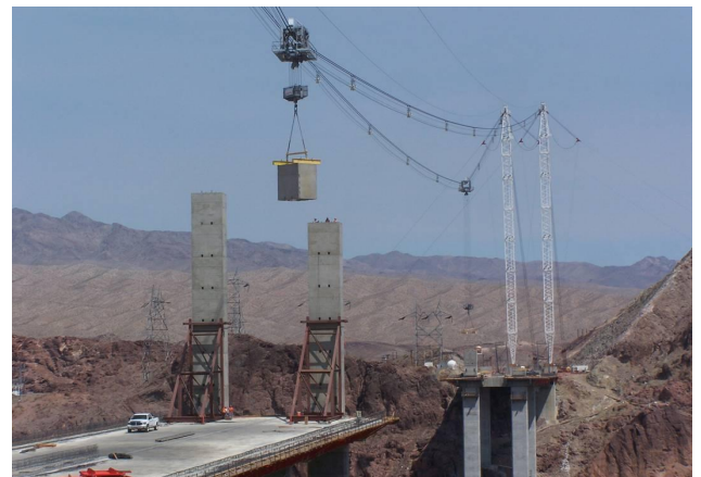
写真-2 ケーブルクレーン使用状況
