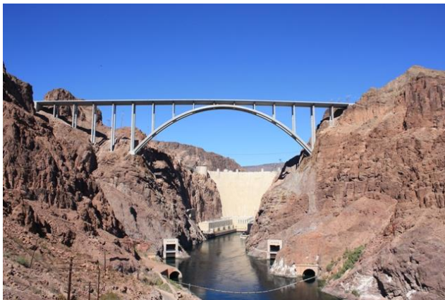
写真-1 フーバーダムと本橋
