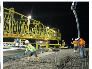
写真-9 床版打設
