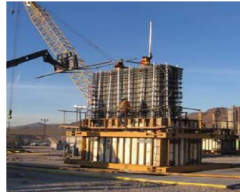
写真-6 セグメント製作
