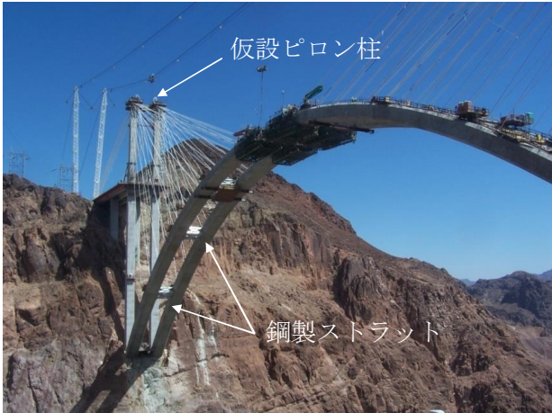
写真-3 アーチ架設状況
