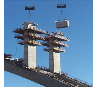
写真-7 セグメント架設
