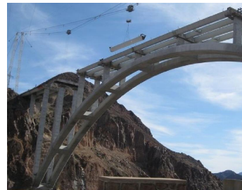
写真-8 鋼桁架設
