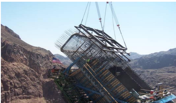
写真-5 ユニット鉄筋の一括架設
