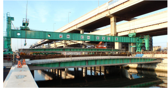
写真-2 主桁架設状況
