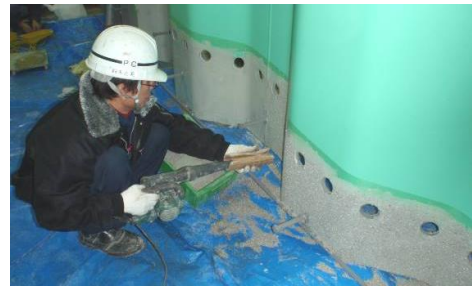
写真-1 珪砂塗布状況
