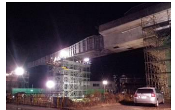
写真-5 押し出し施工状況
