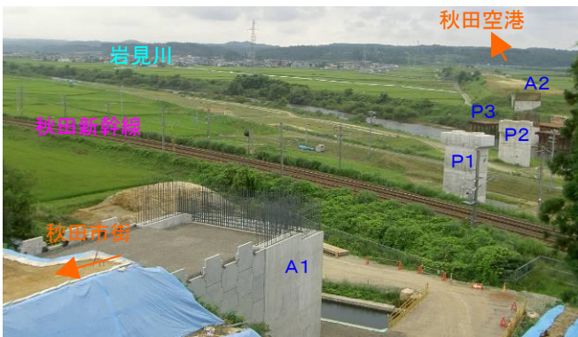
写真-1 上部工着工前
