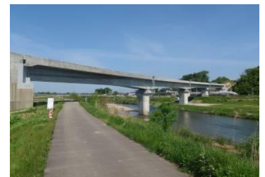
写真-6 完成写真
