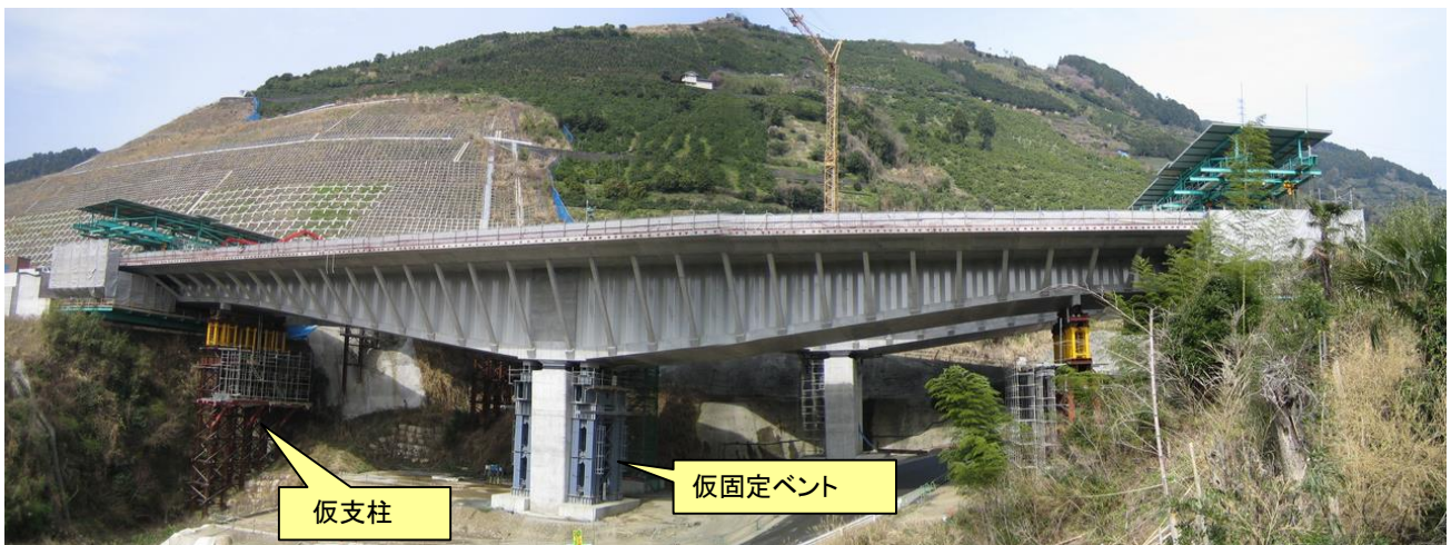
写真-1 片持ち架設状況
