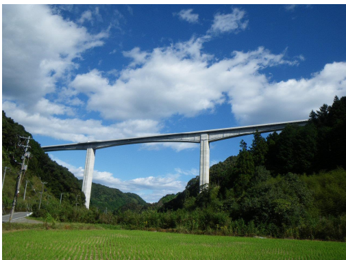
写真-1 工事完了後全景
