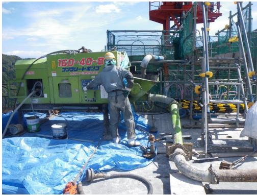
写真-2 定置式ポンプによる二次圧送状況
