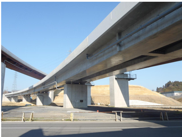
写真-1 完成写真
