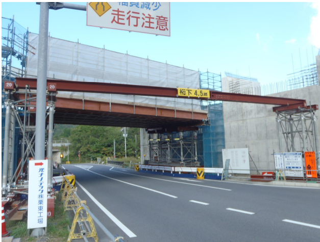
写真-2 支保工防護状況
