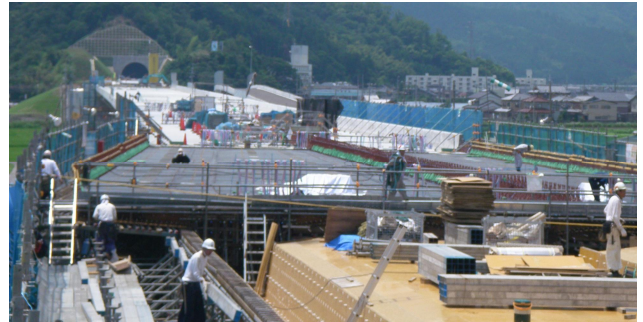
写真-1 主桁と壁高欄の施工状況
