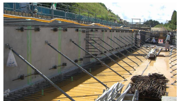
写真-2 プレテンションウェブ設置完了
