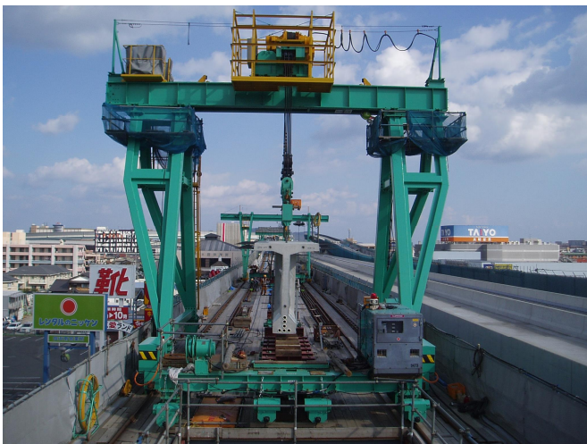
写真-2 セグメント取卸し状況(B渡り線)
