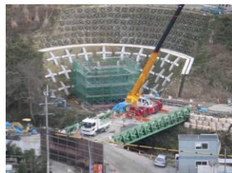
写真-2 工事用仮栈橋
