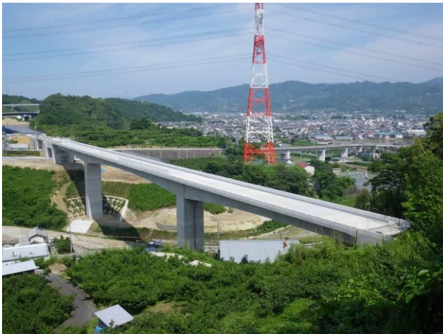
写真-1 完成写真
