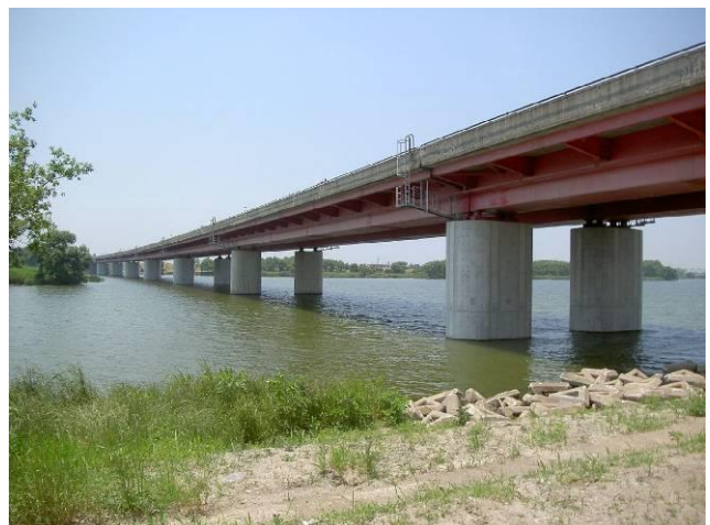
写真-3 工事完了
