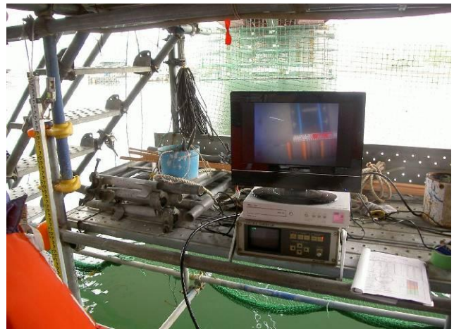
写真-2 水中部の施工管理状況
