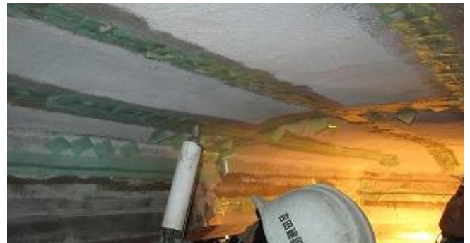
写真-5 被覆材充填状況
