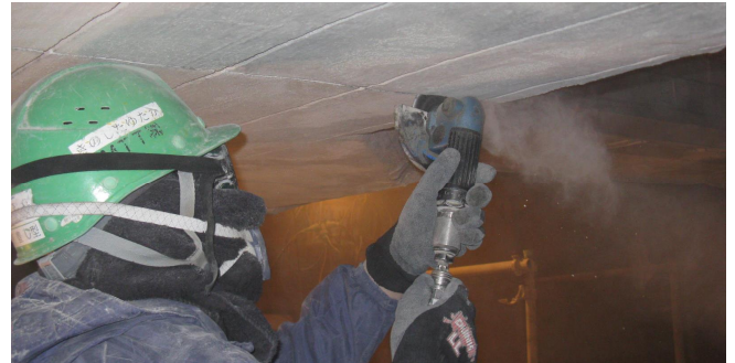
写真-4 溝切り状況
