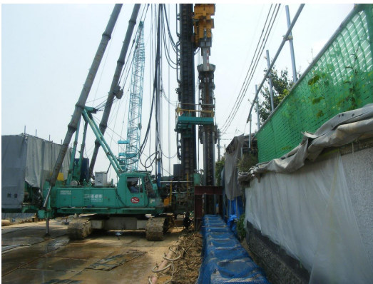
写真-1 H型PC杭施工状況(近接施工箇所)
