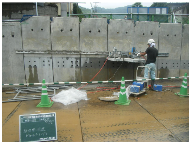
写真-3 杭切断成形状況(ウォールソー切断)
