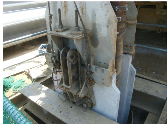
設置し、背面地盤挙動を監視しながら施工を行った。
