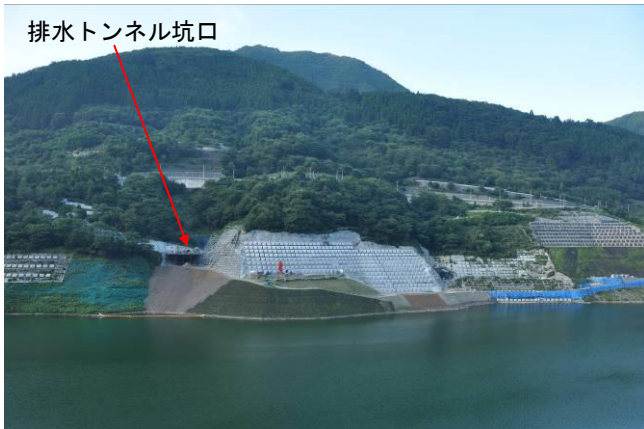
写真-1 施工位置全景 (対岸より)
