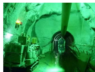
写真-2 坑内状況 (第3試錐座)
