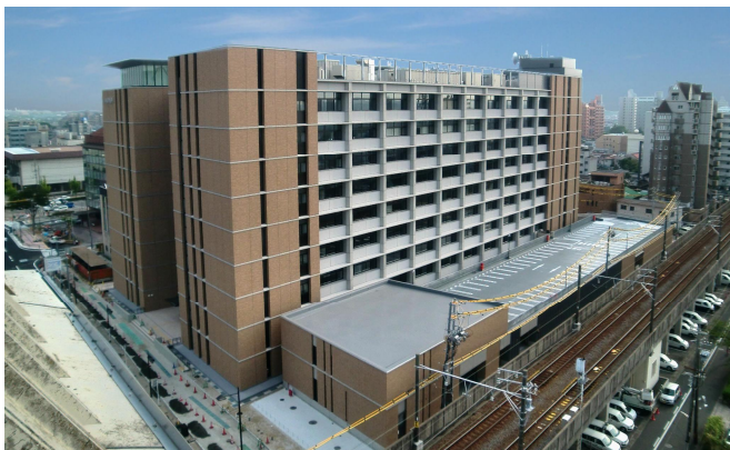
写真-1 新庁舎全景 (竣工後)
