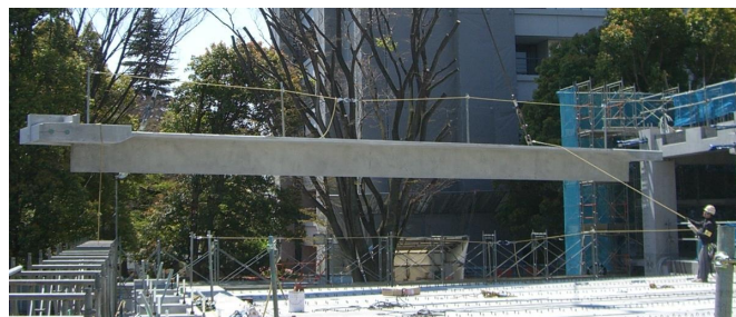
写真-1 ST 合成床板架設状況
