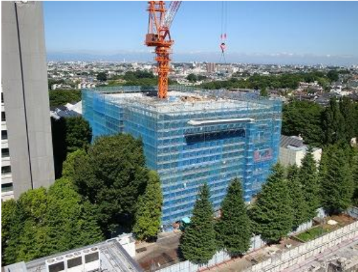
写真-2 施工状況
