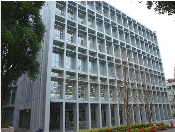
写真-1 建物外観
