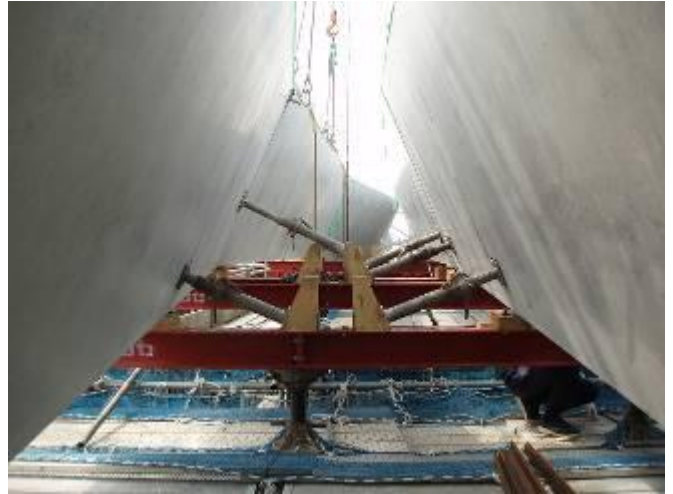
写真-4 建方状況
