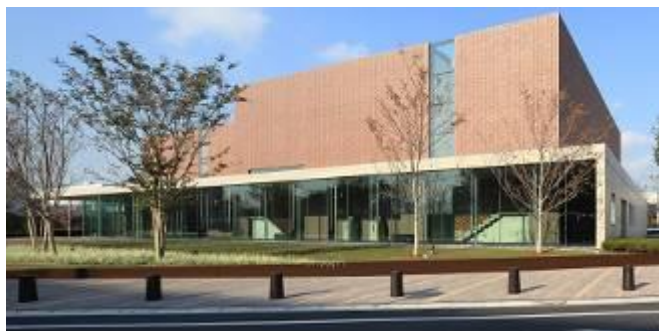
写真-1 伊藤記念ホールの外観 (写真提供: 日建設計)
