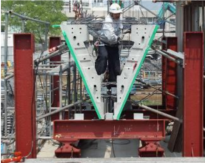
写真-3 地組状況
