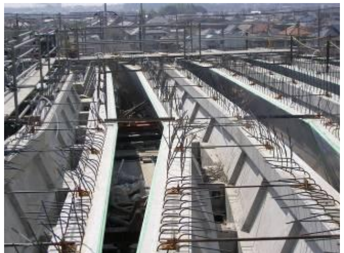
写真-5 PCa折板の固定状況
