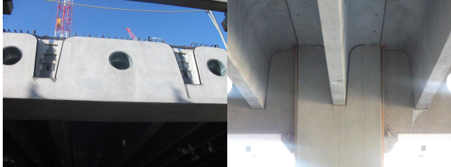
写真-2 大梁側面
