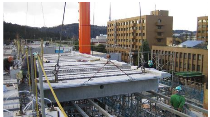
写真-6 片持ち式ST版架設状況
