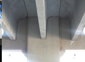
写真-3 柱のST版支承
