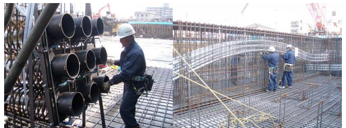
写真-2 緊張端配置
