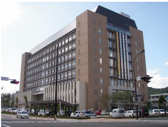
写真-1 庁舎外観 (平成 23 年 1 月 4 日開庁)
