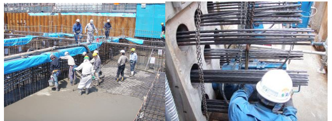
写真-4 耐圧盤打設
