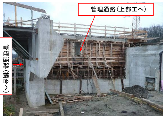
写真-1 新設橋梁 (A40-Sechsstreifiger Ausbau) の橋台部
